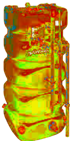
Бак чистой воды со стерильным воздушным фильтром
